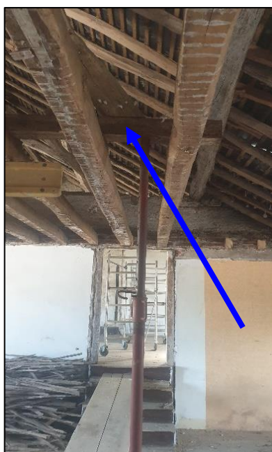
Appui des fermes sur le solivage du 1 er étage
