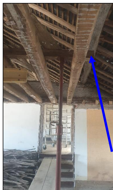
Appui des fermes sur le solivage du 1 er étage
