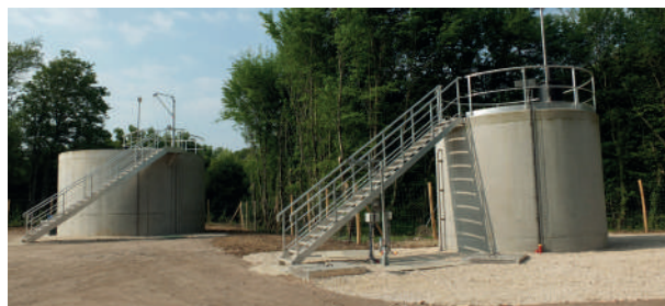
Station d'épuration de Mesland
