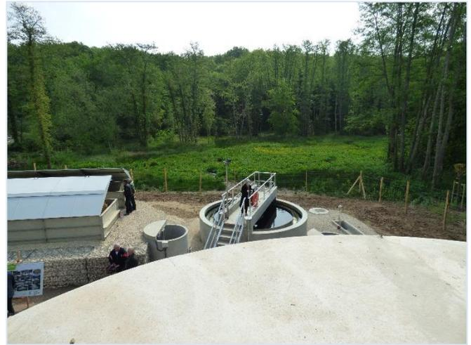
La technologie de l'ancienne station d'épuration, laquelle datait de 1975, ne permettait plus de garantir une qualité de rejet satisfaisante. Agglopolys a donc opté pour la construction d'une nouvelle unité de traitement de type disques biologiques limitant l'impact des rejets sur le milieu naturel. Les eaux traitées alimentent la zone humide qui est protégée.
