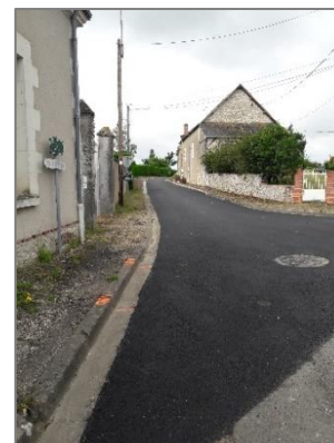
la Rue de la Perdrière (caniveaux et enrobé de roulement) sur 150 m,
