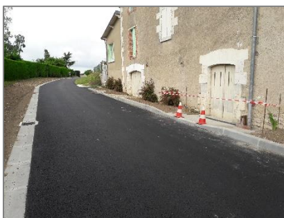
la Route de la Perdrière (reprofilage en enrobé et finition de roulement en bicouche gravillonnée) sur 1.8 km,
