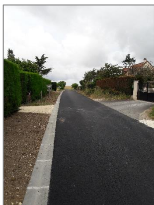
la Rue de la Perdrière (caniveaux et enrobé de roulement) sur 150 m,
