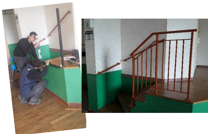
Pose d'une rampe garde-corps-Salle des Associations
